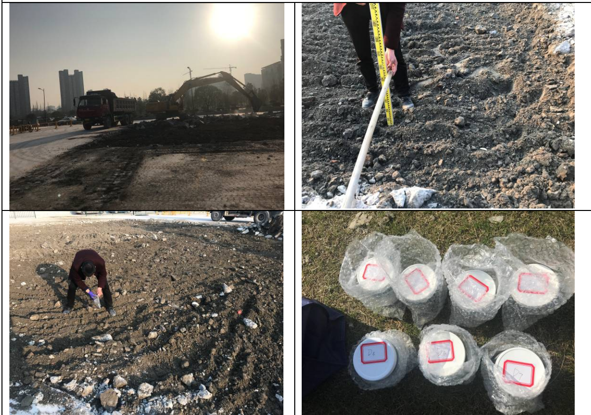
6#区块开挖、采样
