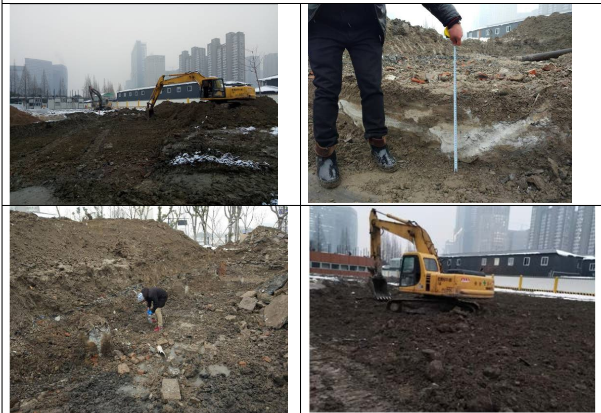
6#区块开挖、采样、回填
